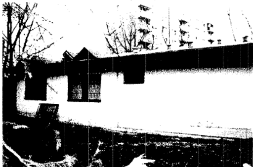
▼ Pohľad zo zadnej časti dvora, na juhozápadné krídlo hotela.
